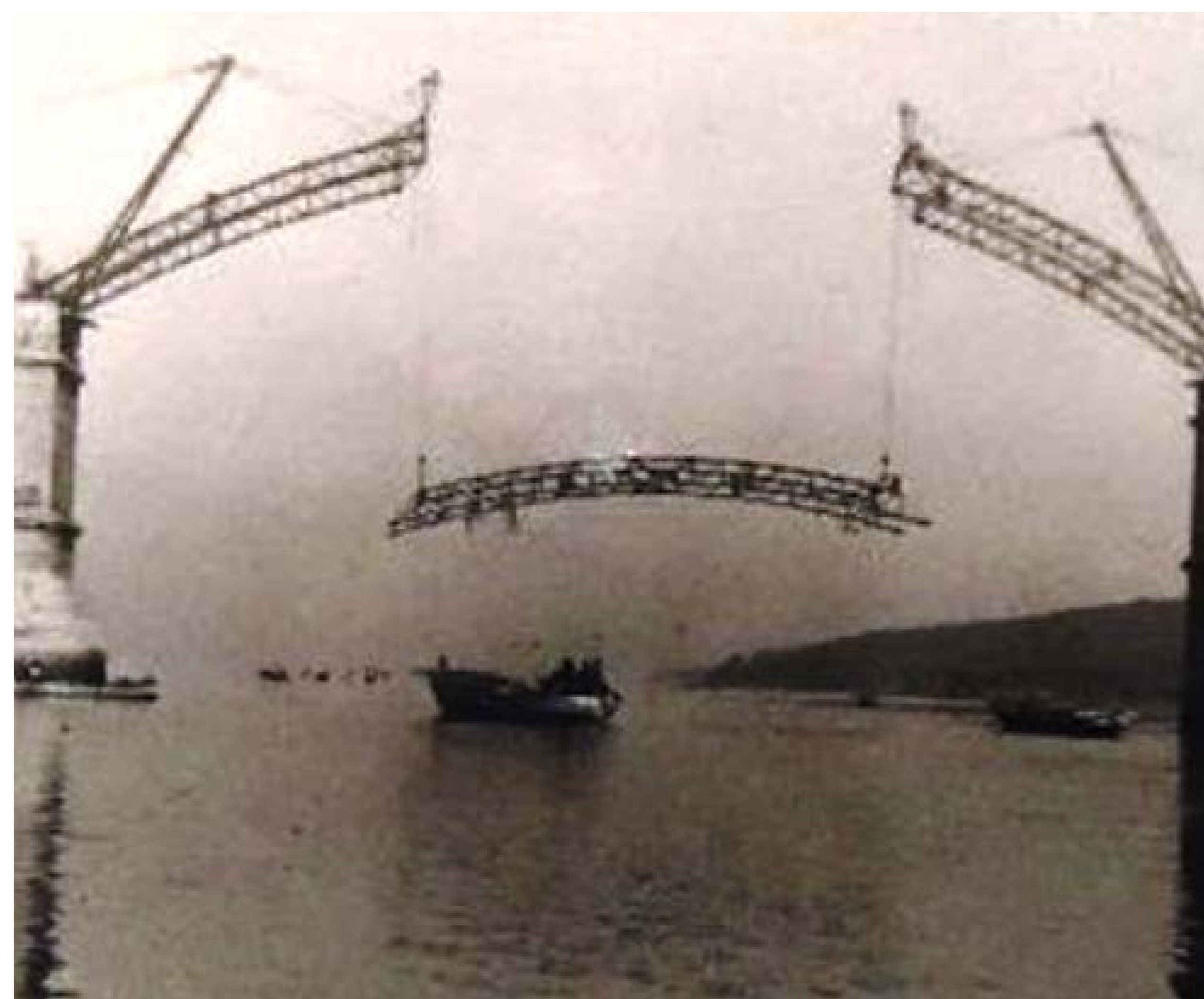
Montaxe do arco central da ponte en 1940
