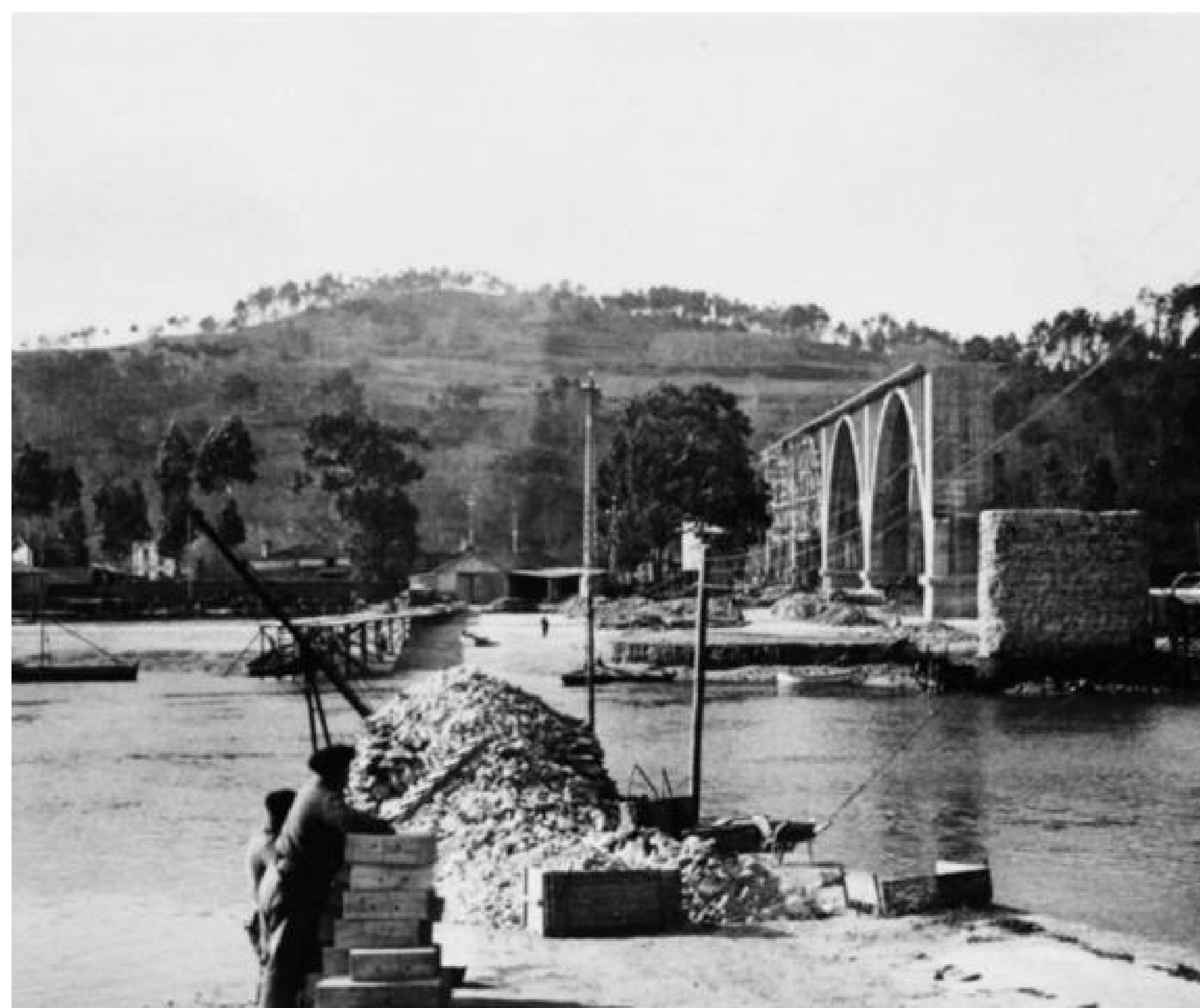
Obras de inicio da construción da ponte do Pedrido, no ano 1936, antes de su paralización pola Guerra Civil
